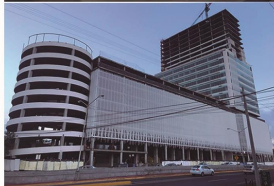
TORRE CÍTICA- MAIZ EDIFICACIONES
